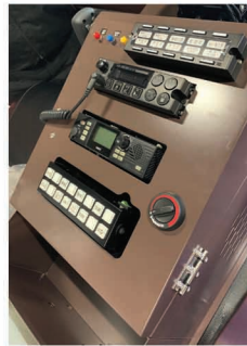
16スイッチコントローラー 埋込設置
