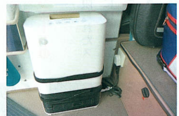
セラミックヒーター専用配線を設置
